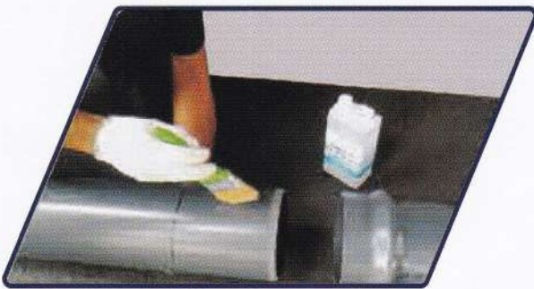
Oleskan Lubricant sekeliling bagian dalam karet RRJ dan dinding luar pipa yang sudah di beri tanda garis hitam sampai ujung spigot
