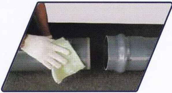
Bersihkan kotoran pada permukaan spigot dan soket RRJ
