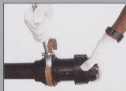
4 Kencangkan "mur pengunci" dengan menggunakan alat pengencang
