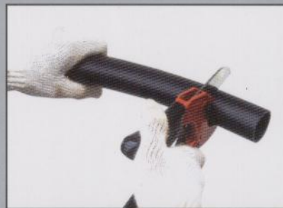
1 Potong pipa tegak lurus dengan gunting atau gergaji, lalu bersihkan ujung-ujung pipa yang akan digunakan.
